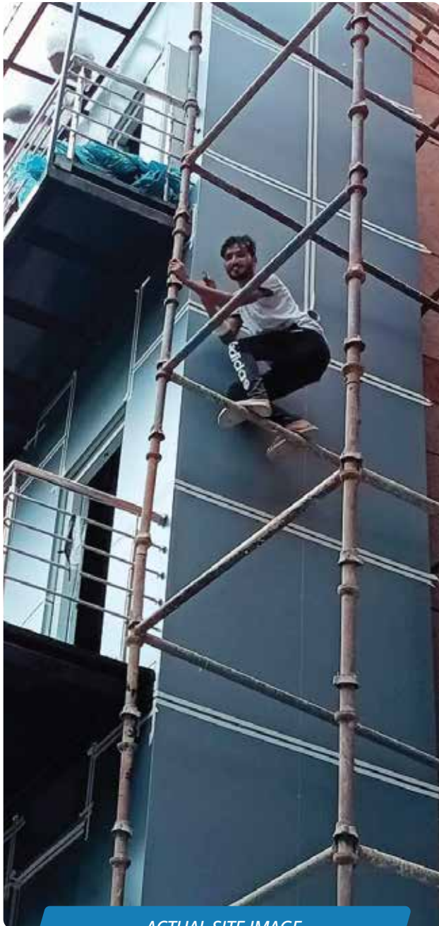
ACTUAL SITE IMAGE
